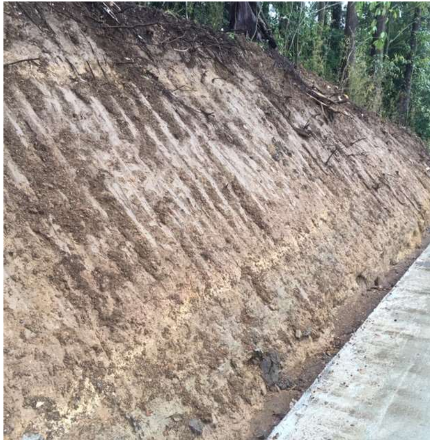
憩いの森周辺・法面
