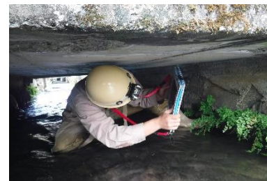
橋りょう点検①
