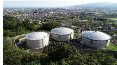
中河原1号配水池耐震補強工事
