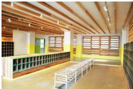
酒匂小学校内装木質化(東昇降口)
