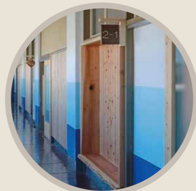
2mの高さに揃えた廊下の木質化
