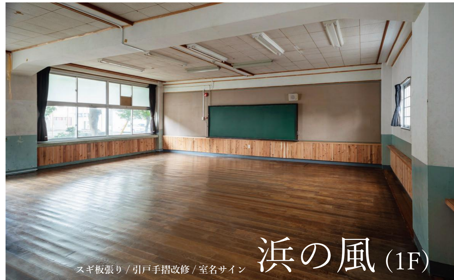
↑ 浜の風は 3 方の腰壁をス ギ羽目板張りとした
