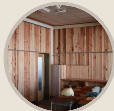
2m材と1m材を組み合わせた板張り
