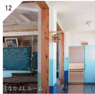
12 間仕切壁撤去+木枠
