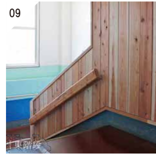
09 階段板張り+手摺
