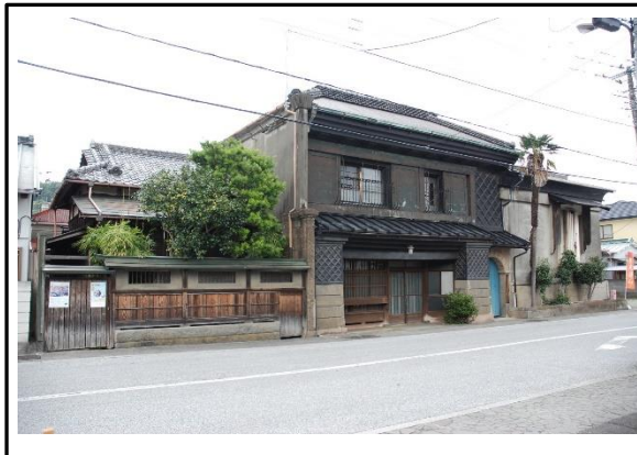
全体外観（南西側）
