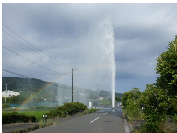
空気弁からの漏水(令和3年・上曽我地内)
