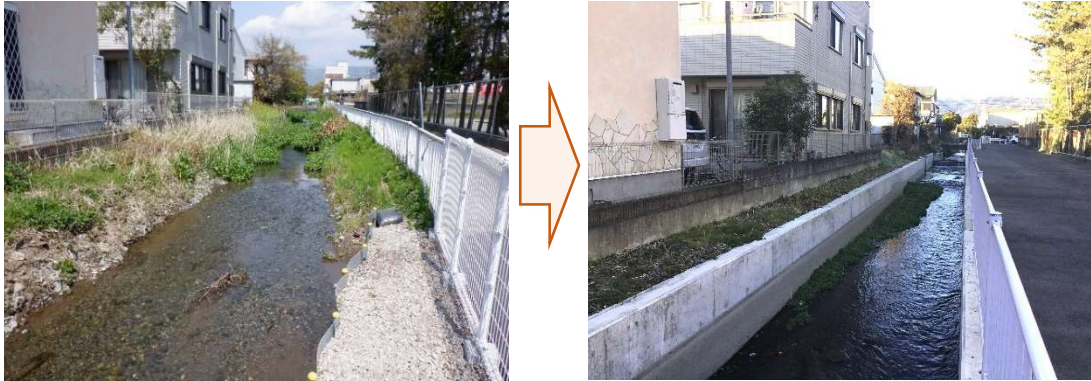
計画的な雨水渠整備の事例
