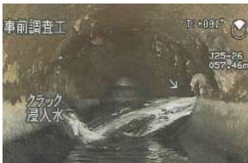
不明水対策(更生工事)前後の管内の状況
