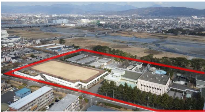
下水道管理センターの様子
