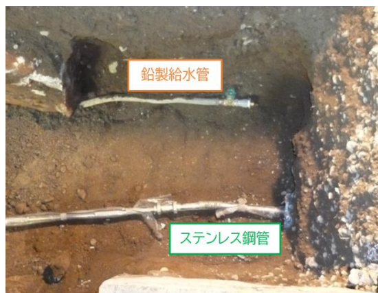
鉛製給水管の布設替え状況
