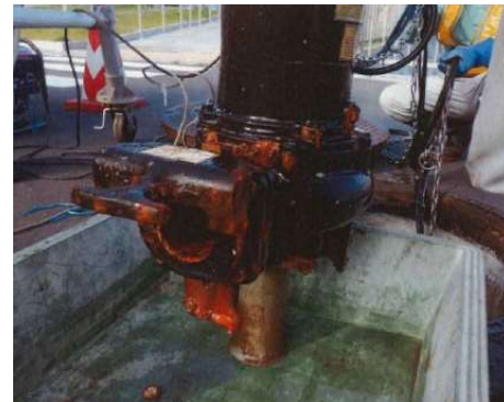
錆が出始めたポンプ設備の状況
