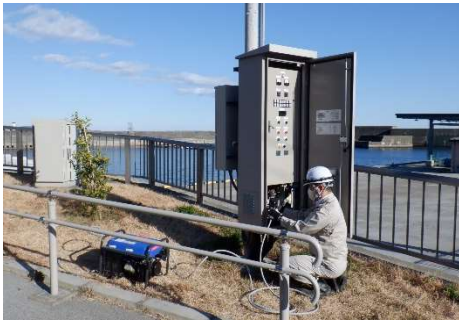
仮設発電機によるマンホールポンプの稼働状況の確認
