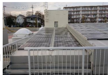
太陽光パネル事例 (川崎市長沢浄水場)
