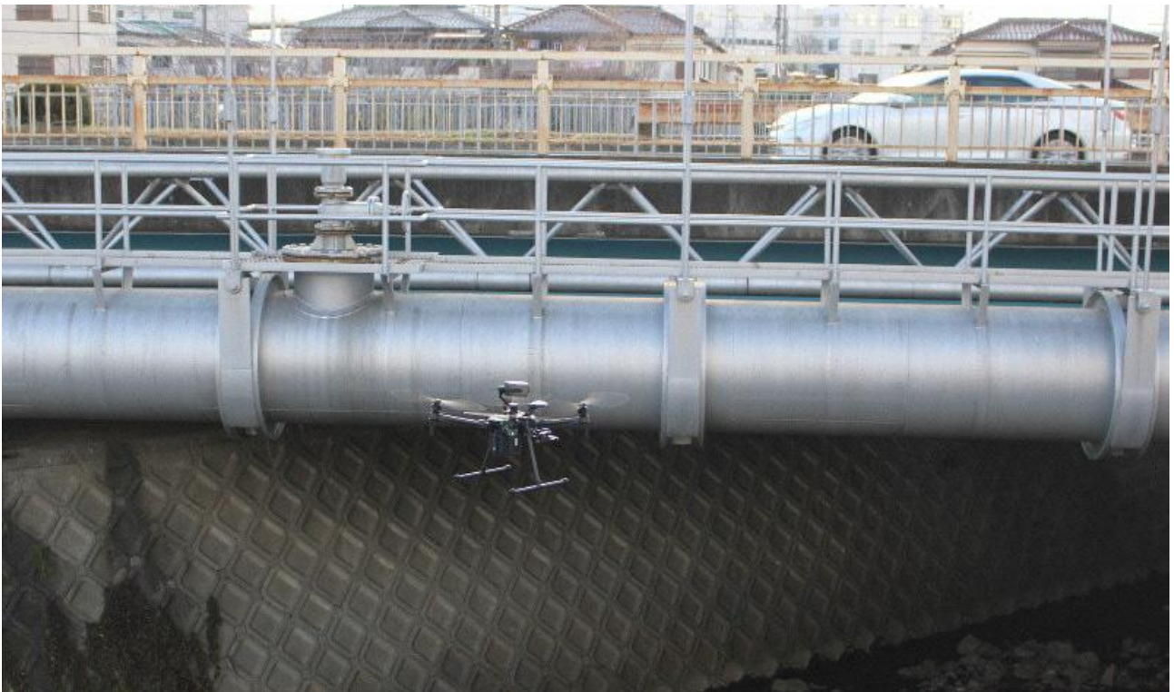
ドローンによる水管橋の点検の様子 (毎日新聞 2020.1.26 記事)
