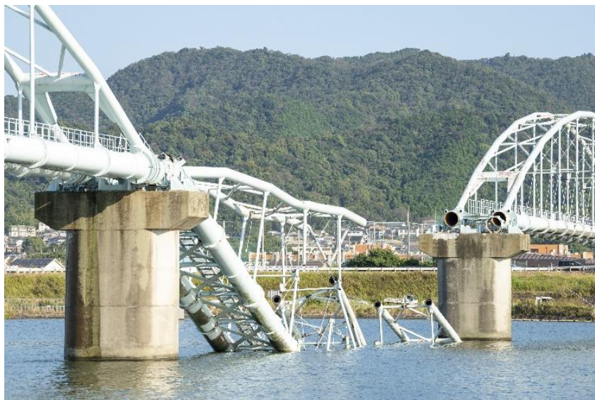
崩落した六十谷(むそた)水管橋
