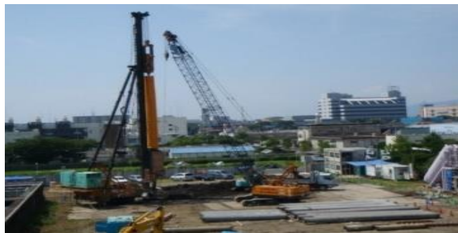
高田浄水場新1号沈でん池杭打ち状況
