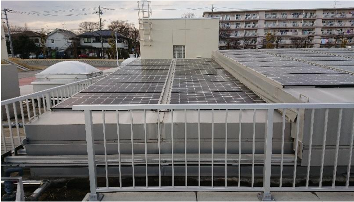
太陽光パネル事例(川崎市 長沢浄水場)
