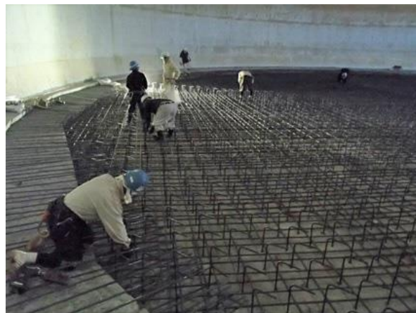
中河原1号池内部の耐震補強の様子
