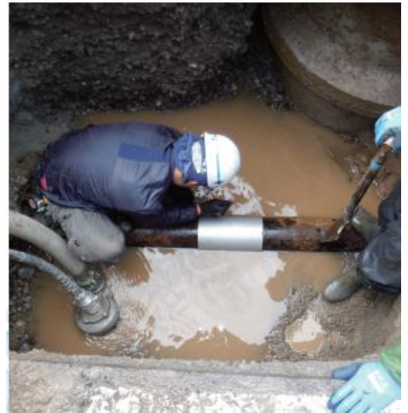
配水管漏水修理の様子
