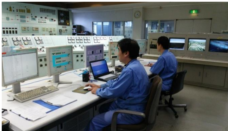
中央監視室の運転状況
