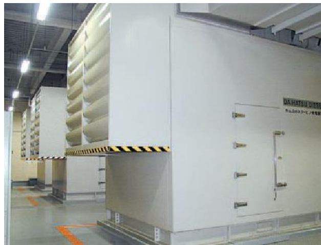
非常用自家用発電設備の設置例 (ガスタービンメーカーHPより)
