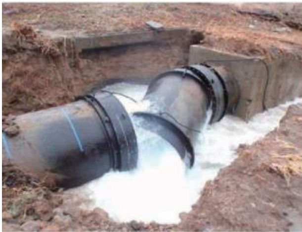
継手が離脱した伸縮可とう管
