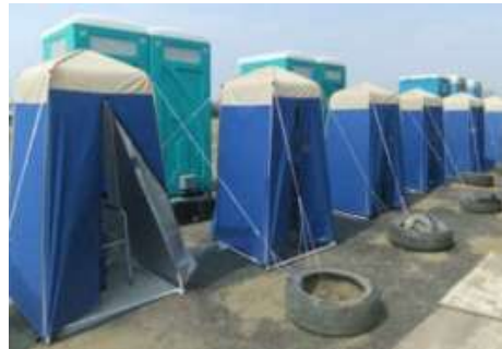
マンホールトイレの設置事例
