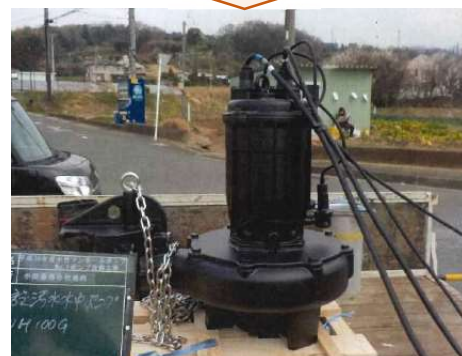
更新後のポンプの状況
