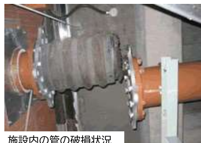
施設内の管の破損状況
