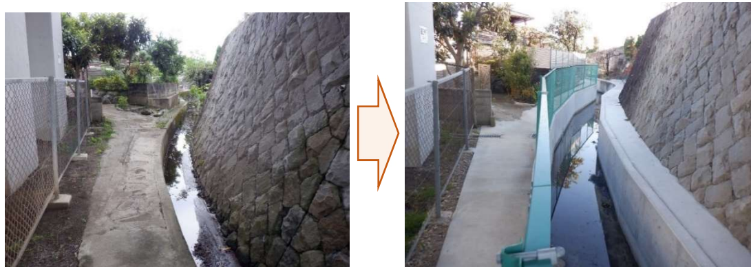
浸水被害解消のための雨水渠整備の事例
