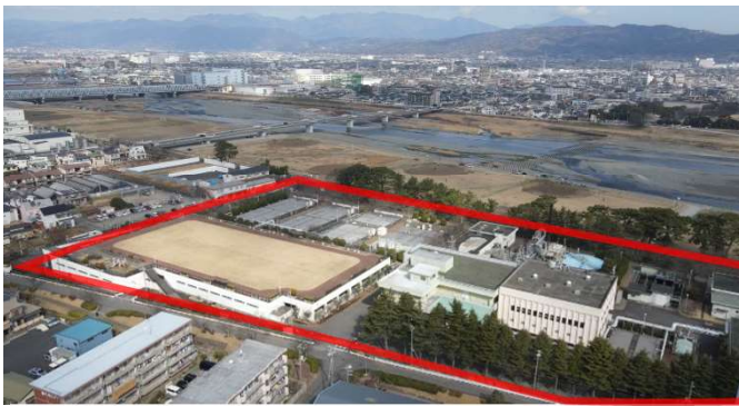
下水道管理センターの様子
