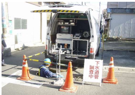
管渠調査の状況
