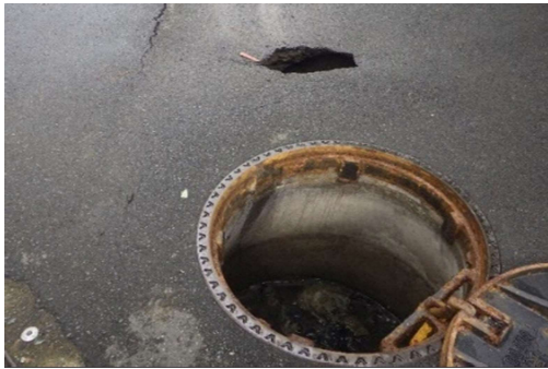
老朽化した污水管渠の破損による道路の陥没
