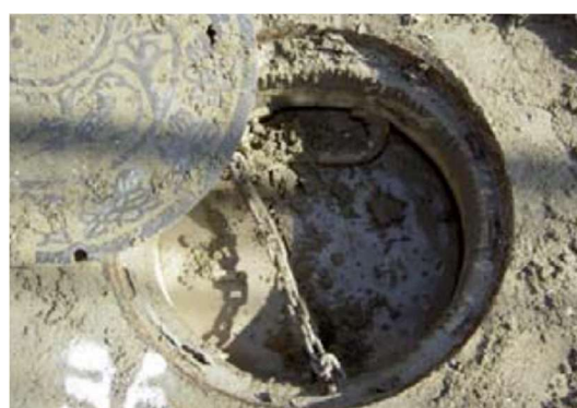
マンホール内の堆積状況
