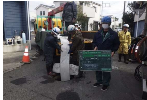
更生工事の施工状況（更生管の入れ込み）
