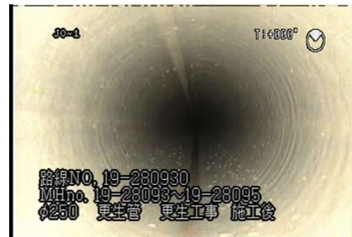
更生工事後の管内部の状況
