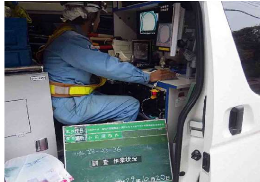
モニターで管内状況を確認しながらカメラを操作
