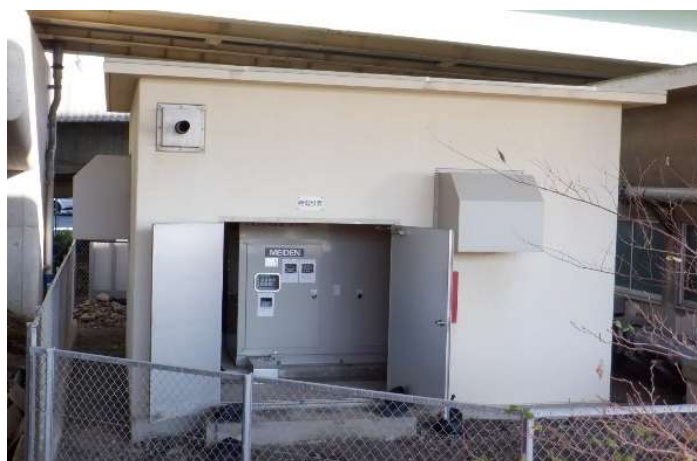
写真 4-3 南町中継ポンプ場の発電機室と自家発電設備
