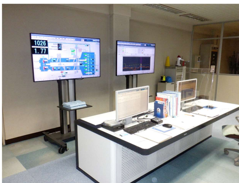
写真 4-7 下水道管理センター内中央監視の状況
