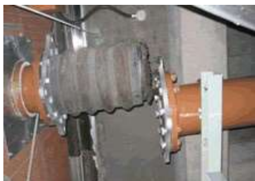
終末処理場における管の破損状況
