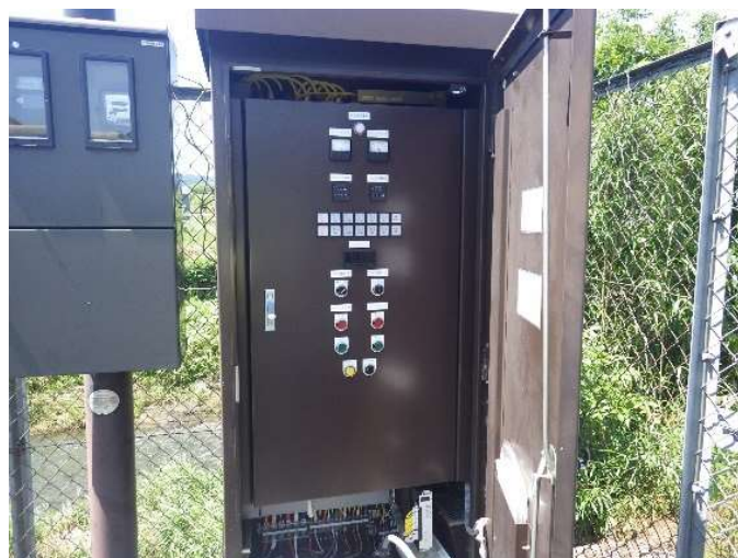
写真 4-6 マンホールポンプの制御盤
