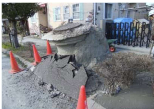
液状化によるマンホールの突出
