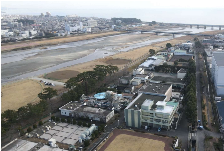
写真 2-1 下水道管理センター上空から酒匂川・相模湾を望む
