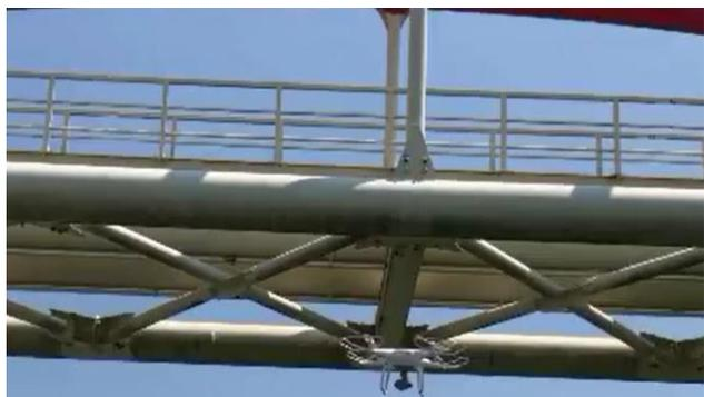
ドローンによる水管橋の点検の様子
