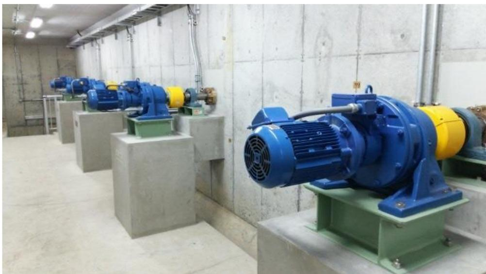
インバータ制御対応モータ(高田浄水場沈でん設備の攪拌機)
