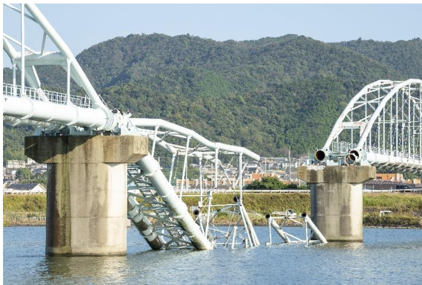
崩落した六十谷(むそた)水管橋
