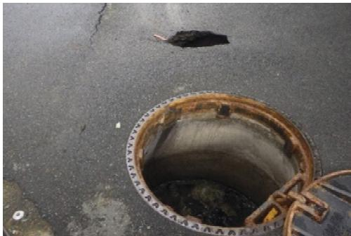
老朽化した汚水管渠の破損による道路の陥没
