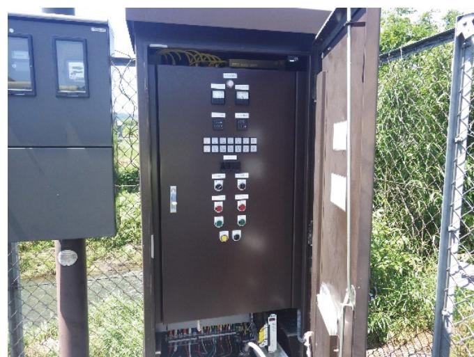
写真 4-6 マンホールポンプの制御盤
