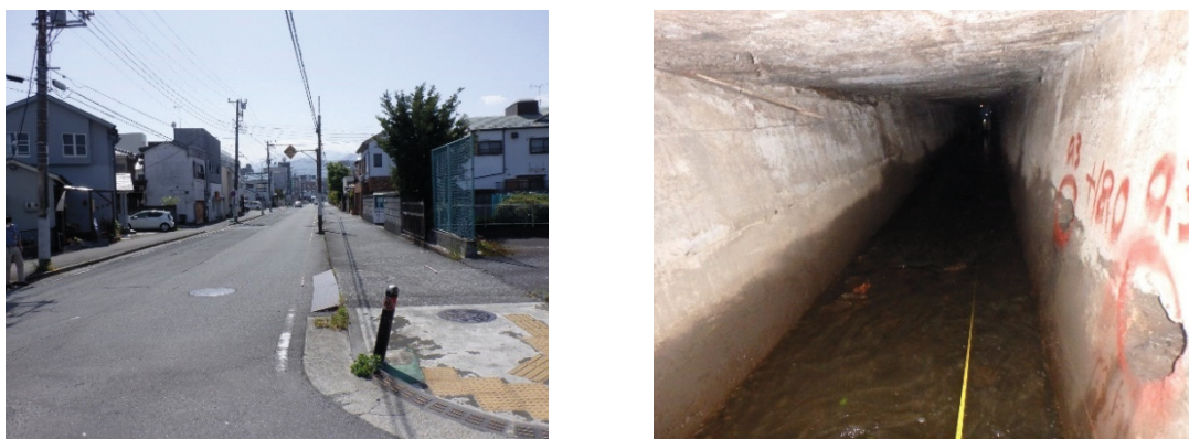
写真 6-2 大下水第一雨水幹線の状況(浜町二丁目地内)
