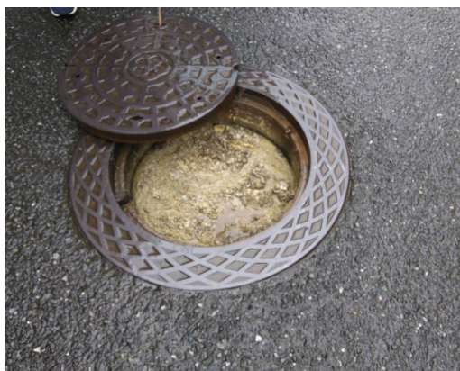
マンホールの詰まりの状況
