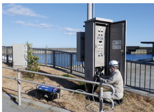
写真 6-6 仮設発電機によるマンホールポンプの稼働確認状況
