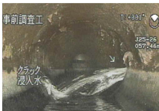
写真 6-12 不明水対策(更生工事)前後の管内の状況
