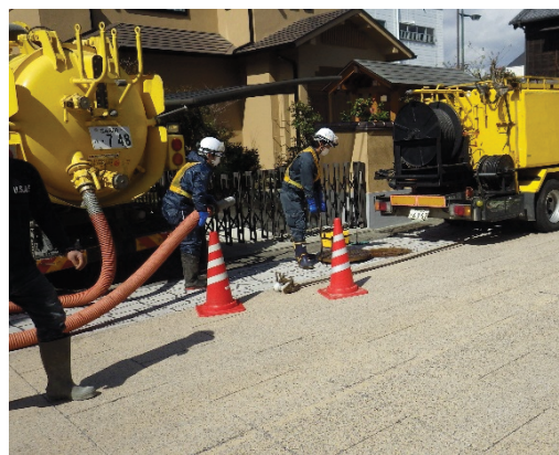
詰まりの改善（浚渫）の状況
