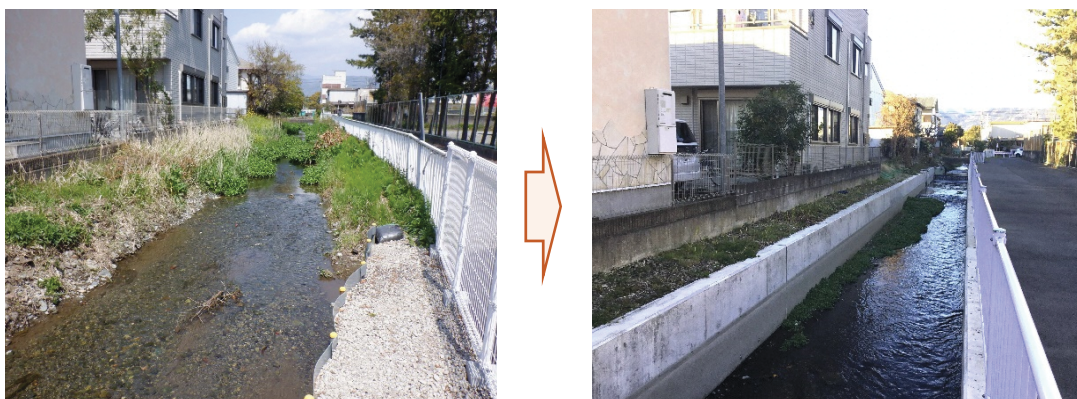
写真 6-1 計画的な雨水渠整備の事例（栢山・曾比地内 寺下第一雨水幹線）
