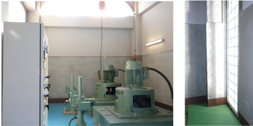
写真 6-4 早川中継ポンプ場建屋内の状況
