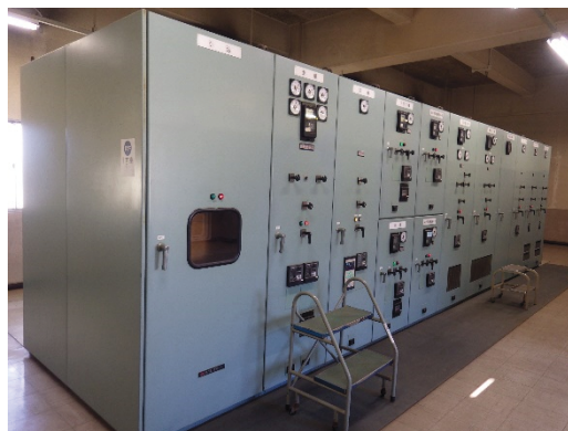
写真 6-5 受変電設備の設置状況
