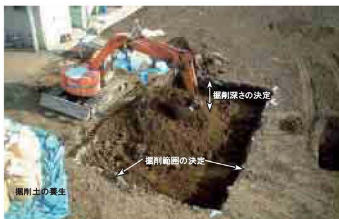
図 8-14 掘削除去の概況写真
