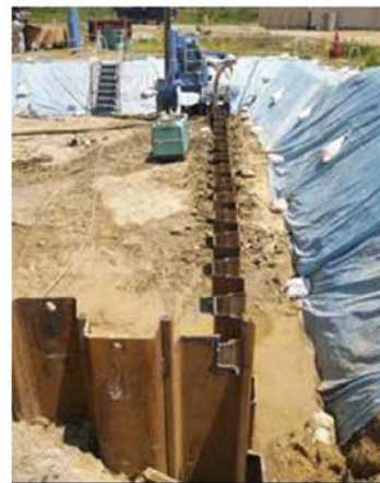
図 8-20 遮水壁（鋼矢板）の打設状況
