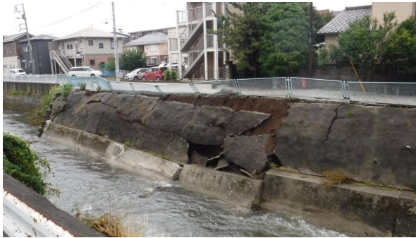
山王川の護岸の崩落
