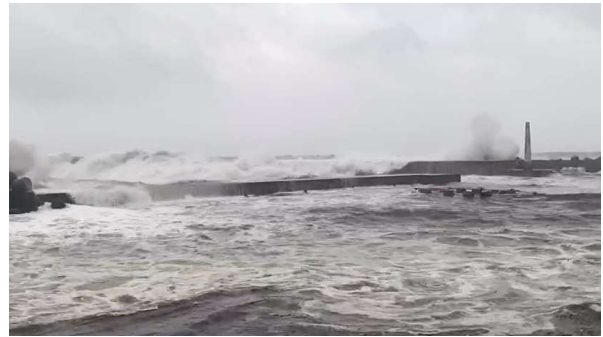
江之浦漁港に打ち寄せる高波
