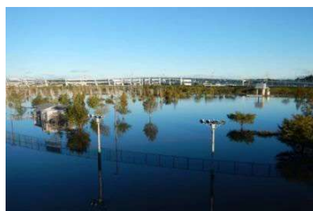
令和元年東日本台風時に、公園と一体となった遊水地が鶴見川の水を貯留し災害を防止するなど、気候変動に伴う災害の激甚化・頻発化への対応に貢献
