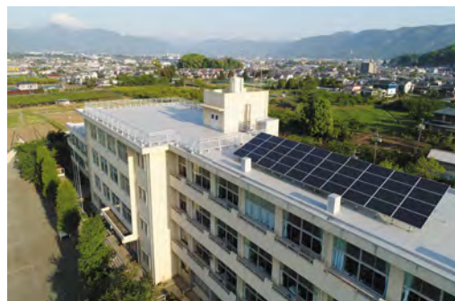
市内小学校に設置した太陽光パネル
