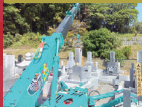
お墓の耐震工事
