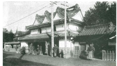
2-127 ういろう薬房全景（関東大地震前）
