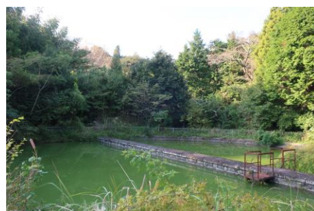
2-99 山縣水道水源地
