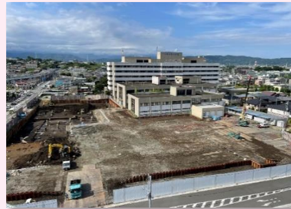
新病院の建設 (工事の進捗状況)
