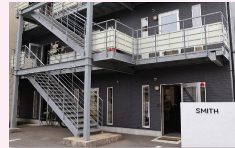
サテライトオフィス等の誘致 (オフィス賃料等補助金、リノベーション費用補助金を活用し、本市に本社を移転した企業)
