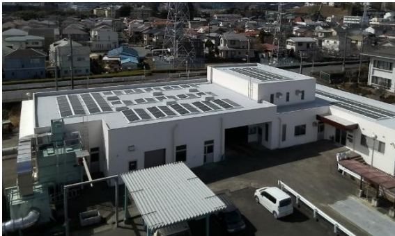
扇町クリーンセンター 設置容量 総出力41.2kW
