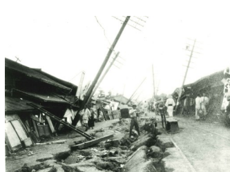
東海道（国道1号）の被害
