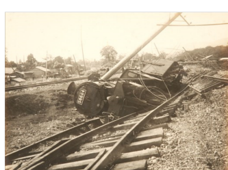
脱線した列車（小田原駅） （横浜開港資料館蔵）
