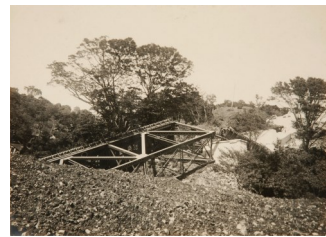
山津波で埋没した白糸川橋梁※
