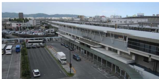
小田原駅西口広場
