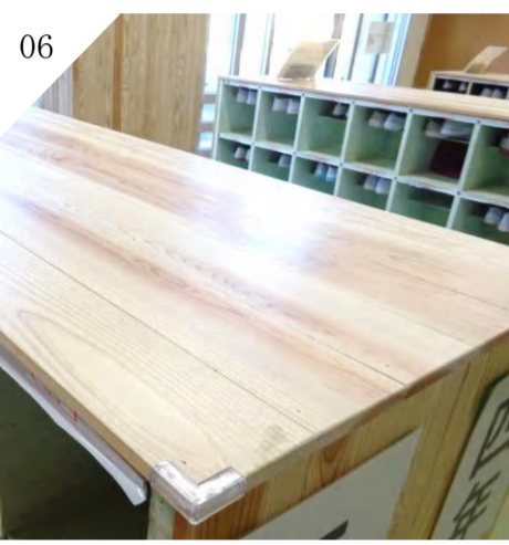
06 下駄箱天板板張り
