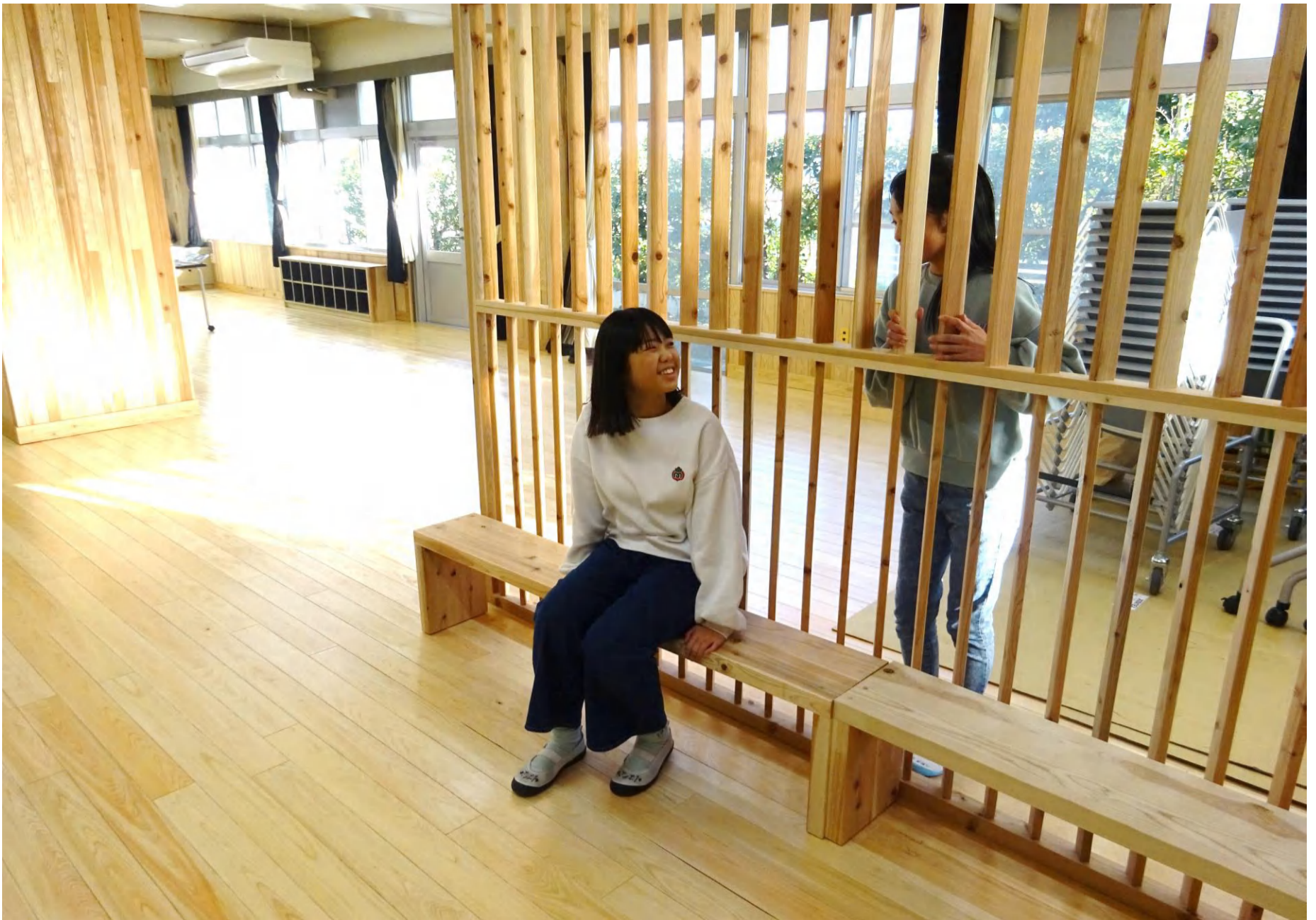
木製ルーバーを設置し、室内を多目的利用と収納機能に区別できる形としました。壁にせず、あえてルーバーにすることで自然光を取り入れ、明るい空間を維持しており、ちょっとした子どもの遊び場にもなっています。
