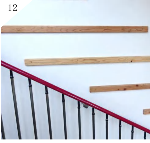
12 スギ板横張り (手すり調)
