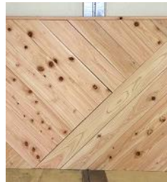
腰壁板張り (ヒノキ:斜め)
