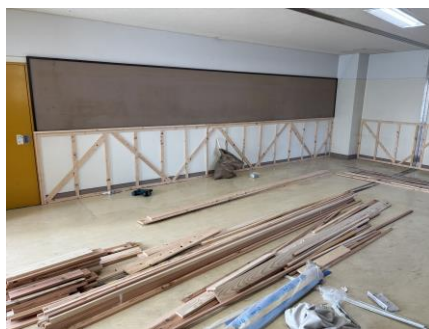
下地、板張り工事・什器製作
