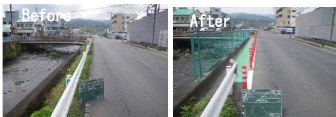
乗降スペースの確保に向けた整備
