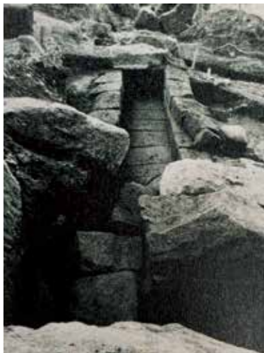
写真3 鉄門跡の石組水路
