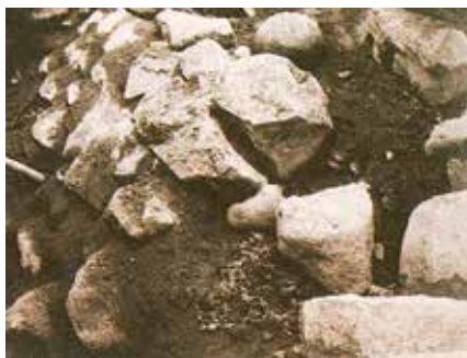
写真11 初期天守台の石垣
