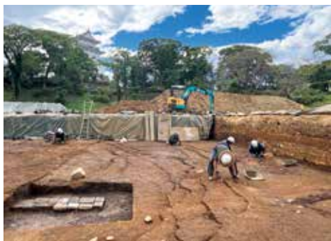
写真25 寛永小田原大地震による地割れ
