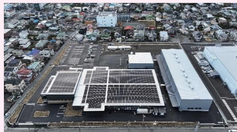
太陽光発電設備(市内事業所)
