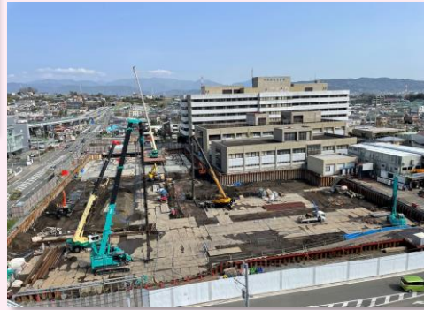
新病院の建設 (工事の進捗状況)
