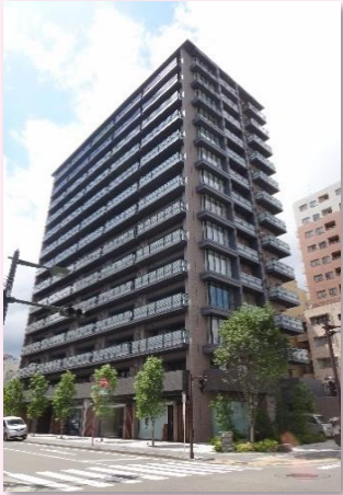
小田原駅周辺(西口・東口)の再開発事業の促進 優良建築物等整備事業により 整備が完了した栄町二丁目地区
