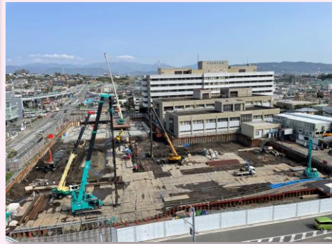
新病院の建設 (工事の進捗状況)
