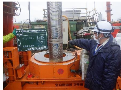
ケーシング挿入状況 (全自動溶接)
