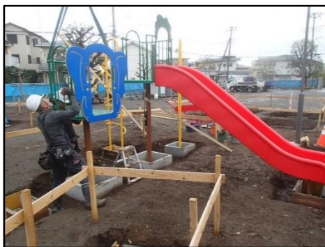
複合遊具設置状況
