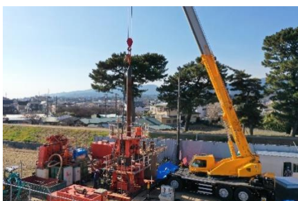
既設ケーシング引上げ状況
