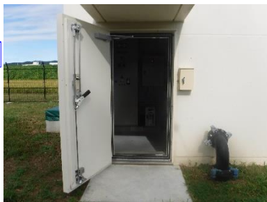
止水扉設置状況
