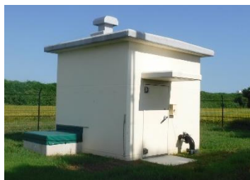
ポンプ室更新後
