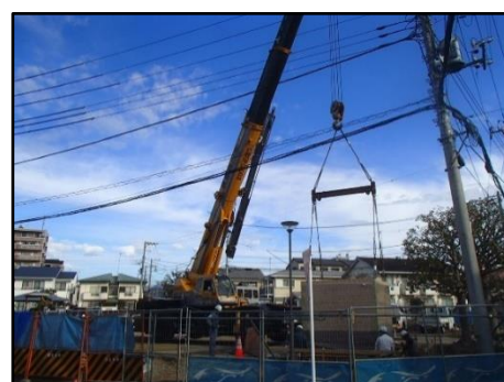
トイレ設置状況
