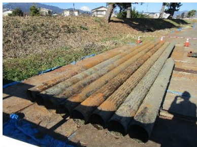
既設ケーシング
