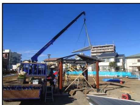
あずまや設置状況
