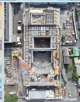
上空からの全体写真
