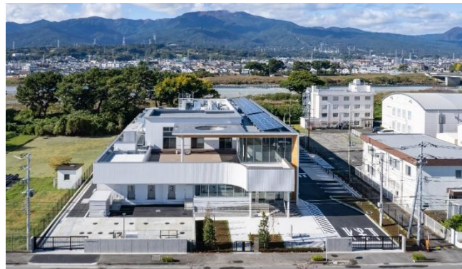
【学校給食センターの全景】
