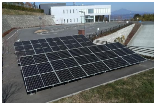
斎場南側駐車場奥
