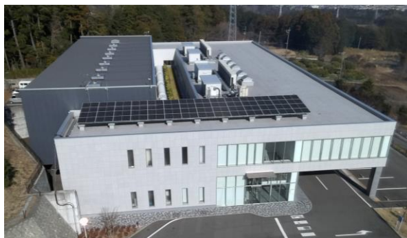
斎場屋上南側
