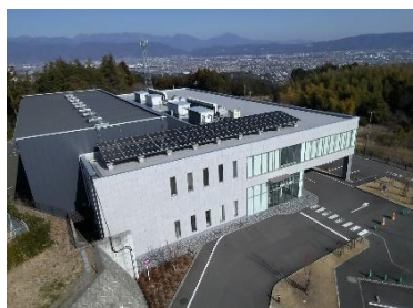
小田原市斎場 設備容量 総出力34.1kW
