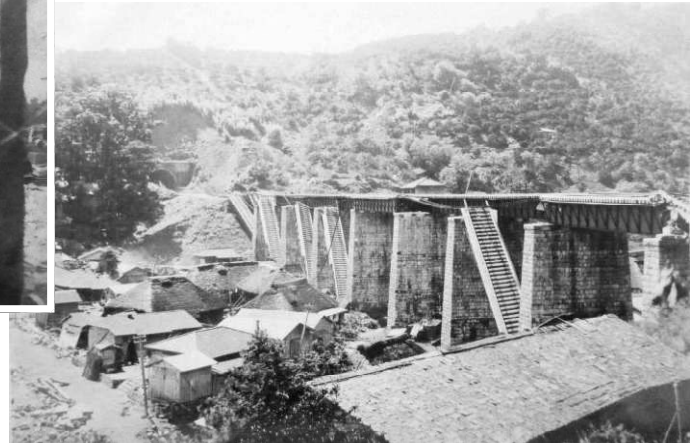
橋桁がはずれた熱海線の玉川橋梁（当時片浦村石橋）
