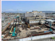
新病院の建設 (工事の進捗状況)
