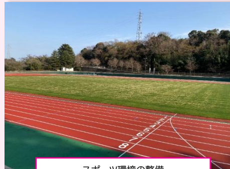
スポーツ環境の整備 (城山陸上競技場改修)
