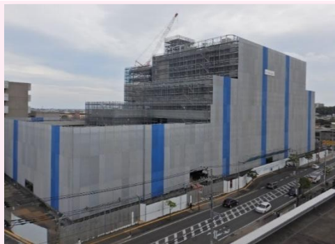
新病院建設工事進捗状況
