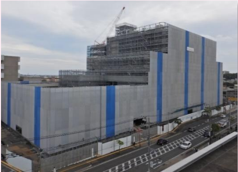
新病院建設工事進捗状況
