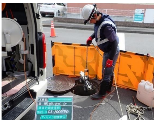
テレビカメラ調査作業状況
