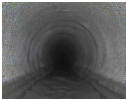
下水道管内状況
