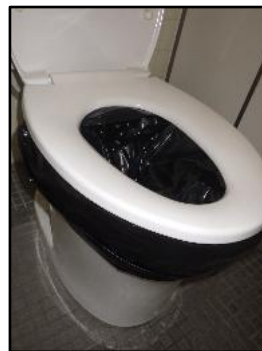
施設トイレを活用した携帯トイレ
