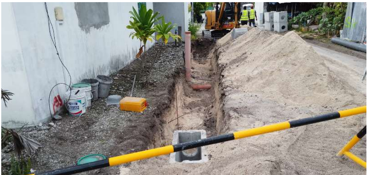
電線地中化工事の様子
