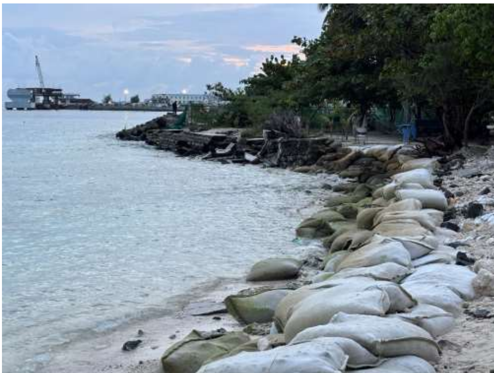
土のうで応急処置しているピリンギリ島の海岸
