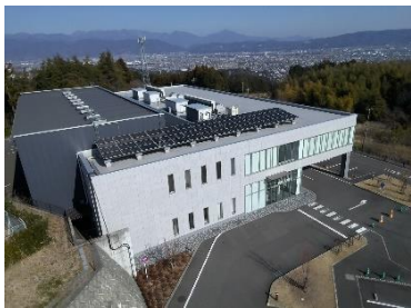
小田原市斎場 設備容量 総出力34.1kW
