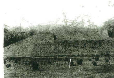
天守解体後の天守台の石垣 （小田原市立中央図書館）
