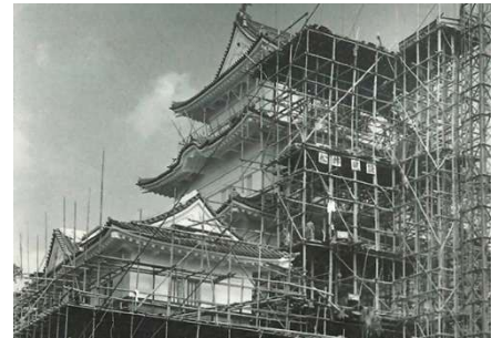
建設中の小田原城 昭和35年(1960)
