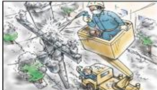
停電防止のため碍子等の清掃（降灰除去）が必要
