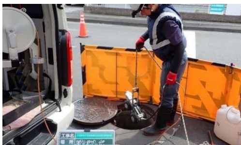
【テレビカメラ調査作業状況】
