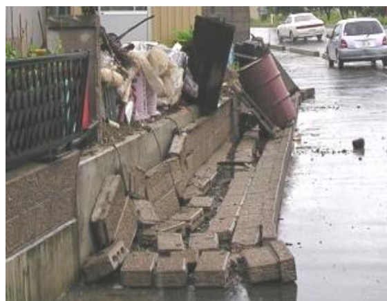
ブロック塀倒壊の状況
