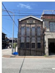
山車小屋の修景
