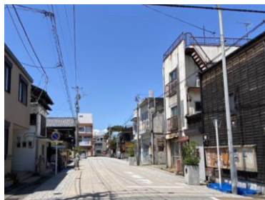
景観に配慮した道路改良
