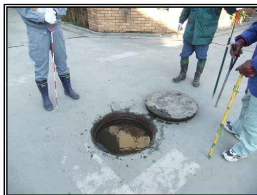
マンホール内の堆積状況
