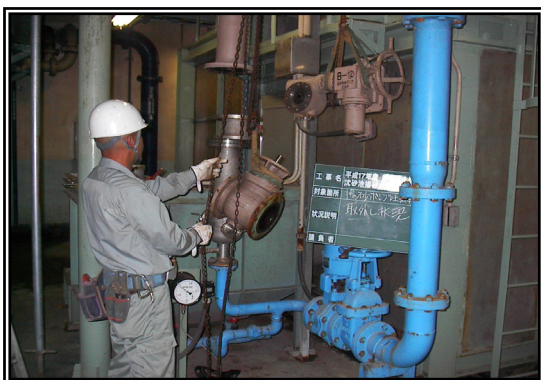
揚砂ポンプの修繕作業
