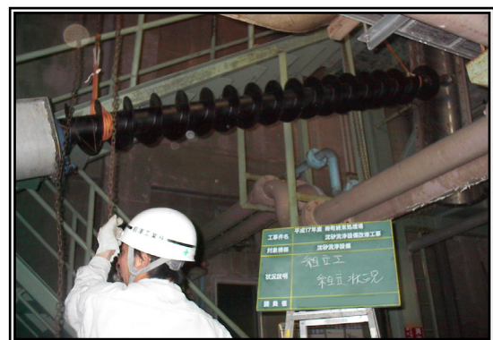
スクリーコンベアトラフの更新作業
