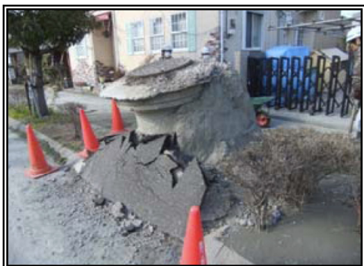
マンホールの突出
