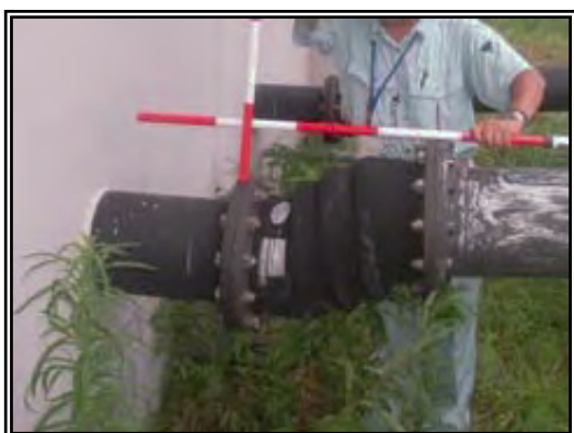
下水処理場施設の管路破損状況
