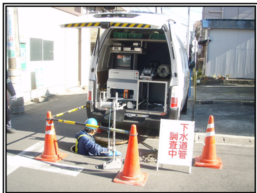
管路調査の状況
