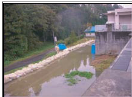
処理場付近で流出する未処理汚水の状況
