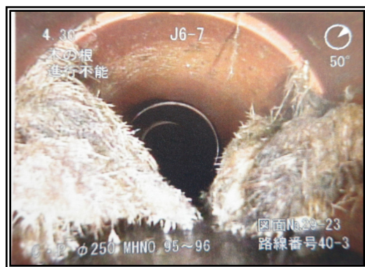
侵入根が通水断面を阻害
