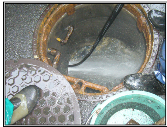
管きょ洗浄作業の状況
